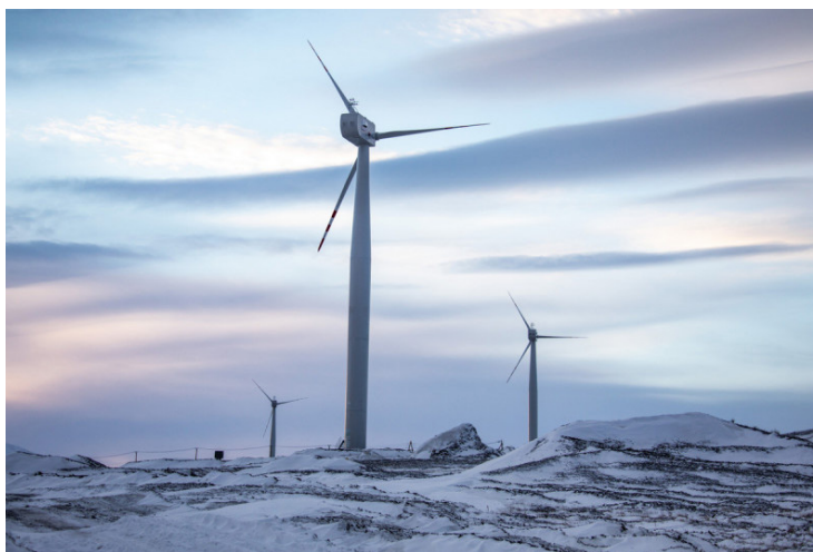
Рисунок 1. Ветроустановки на арктическом побережье
