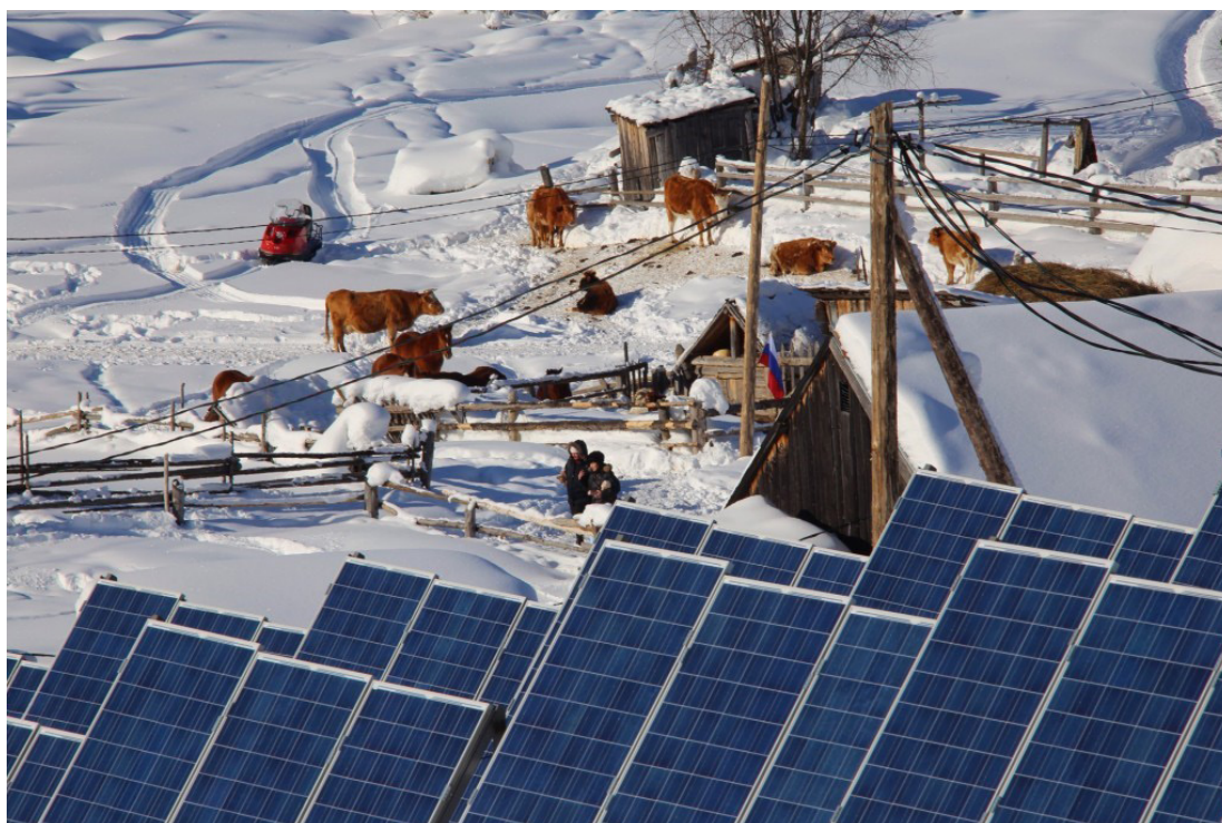
Рисунок 5 – Солнечная электростанция. Село Юнкюр, Верхоянский район, республика Саха (Якутия) 5 .
