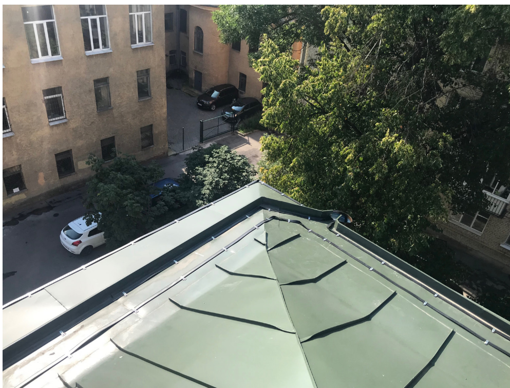
Рисунок 1 – Система антиобледенения кровли (пример)..
